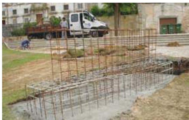
25.Maio.2007 - Construção da base do monumento.
