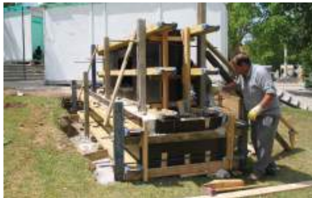
01.Junho.2007 - Construção da base do monumento.
