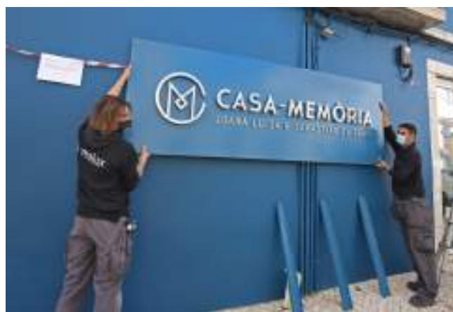
Logotipo e identificação exterior do espaço, em fase de colocação
